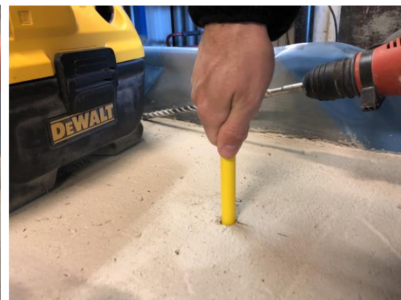
Rör med tätning i botten monteras.
