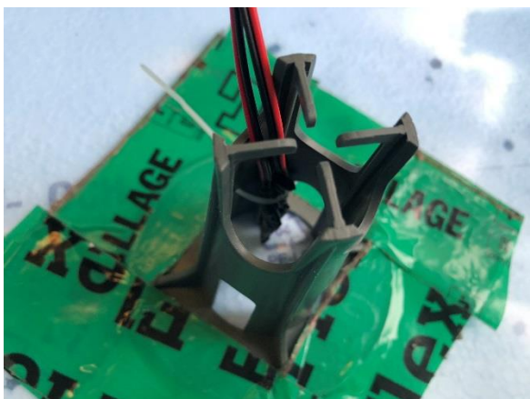
Temperaturslingor fästs i distans i botten och 75 mm från botten.
