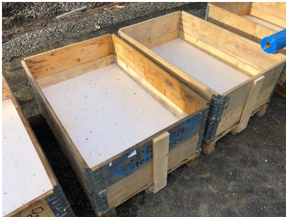
Nästa pallkrage skruvas fast för ökad stabilitet.
