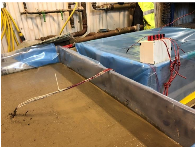
Figur 40. Slingor kopplade från betong till Betongdatorn samt från omgivande luft.
