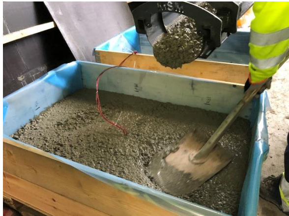
Med skyffel bearbetas betongen.
