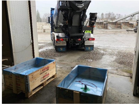
Betongen transporteras till formarna.
