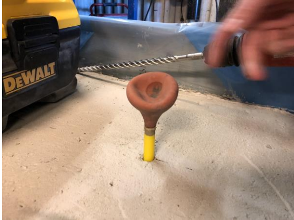
Rör kontrolleras så att det är tätt i botten.
