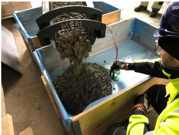
Betongen fylls i form, distans hålls på plats.
