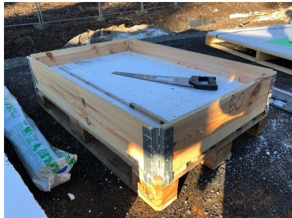
Cellplast monteras efter pallkragens mått.
