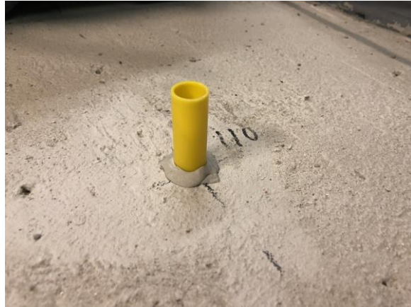
Röret tätas med tätningssmassa
